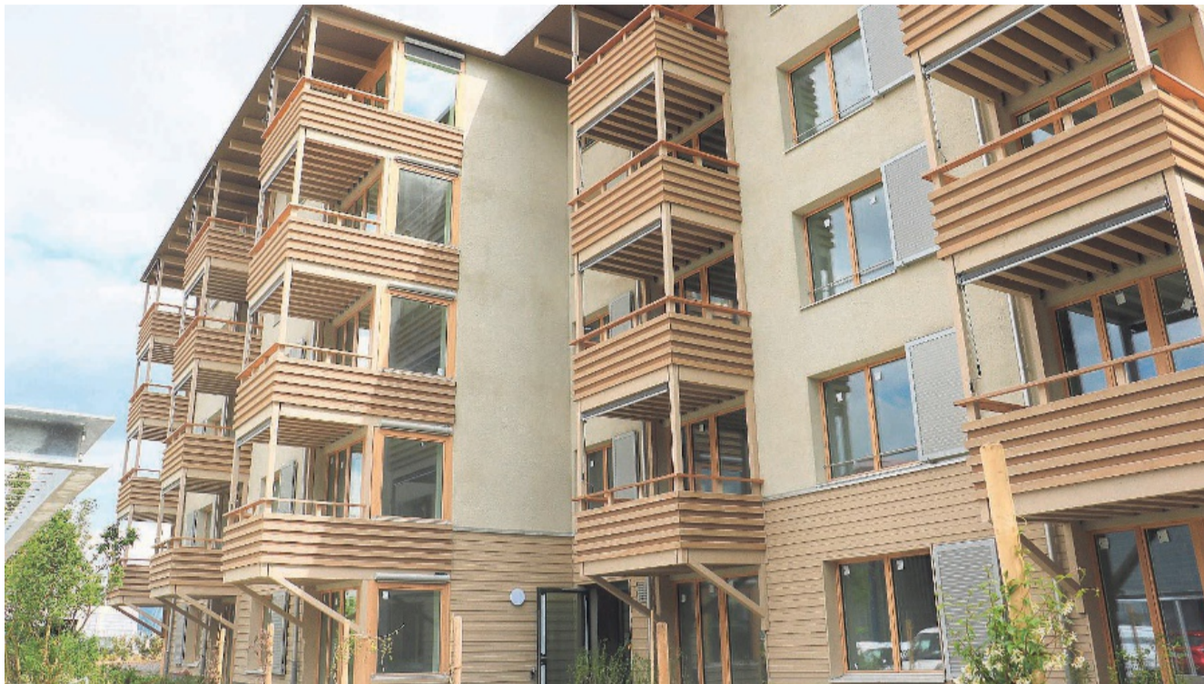
Alle Balkone der Liegenschaft an der Freihofstrasse sind auf den Zürichsee ausgerichtet.
