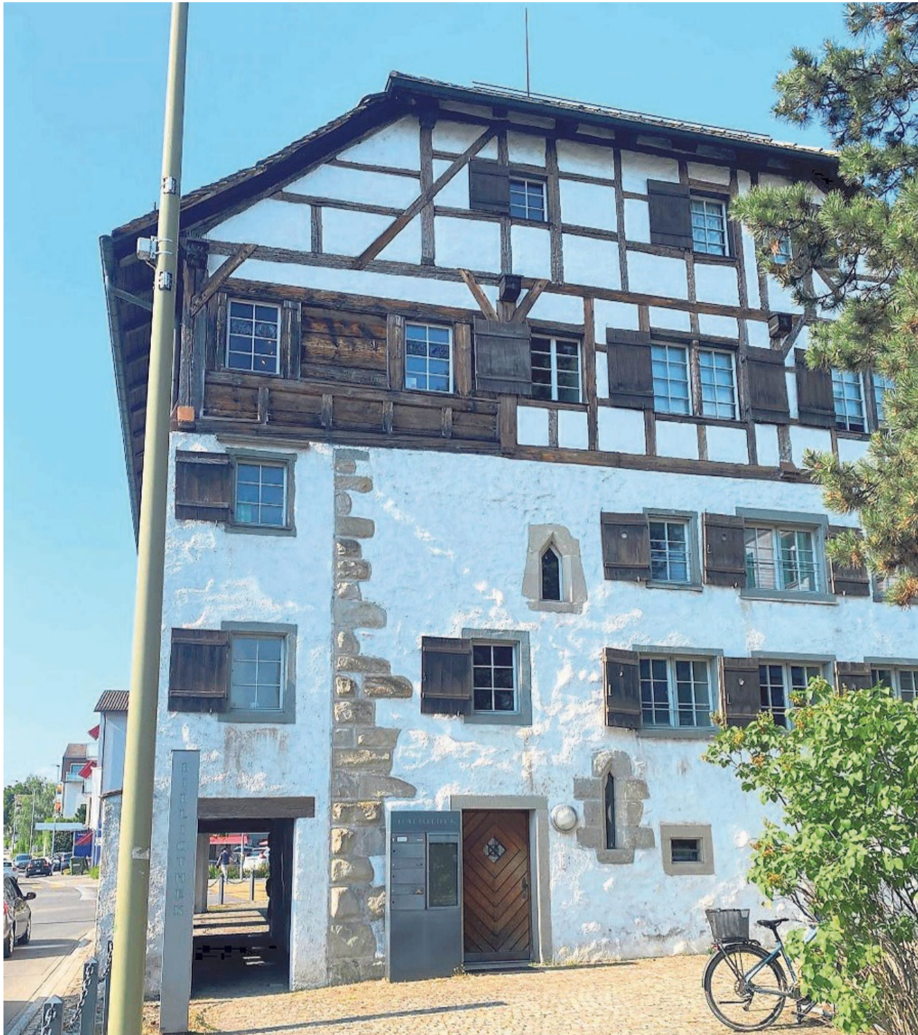
Eines der ältesten Gebäude im Kanton und älter als die Eidgenossenschaft: Das Höchhus – zürichdeutsch für hohes Haus – wurde 1235 erbaut. BILD ZVG
