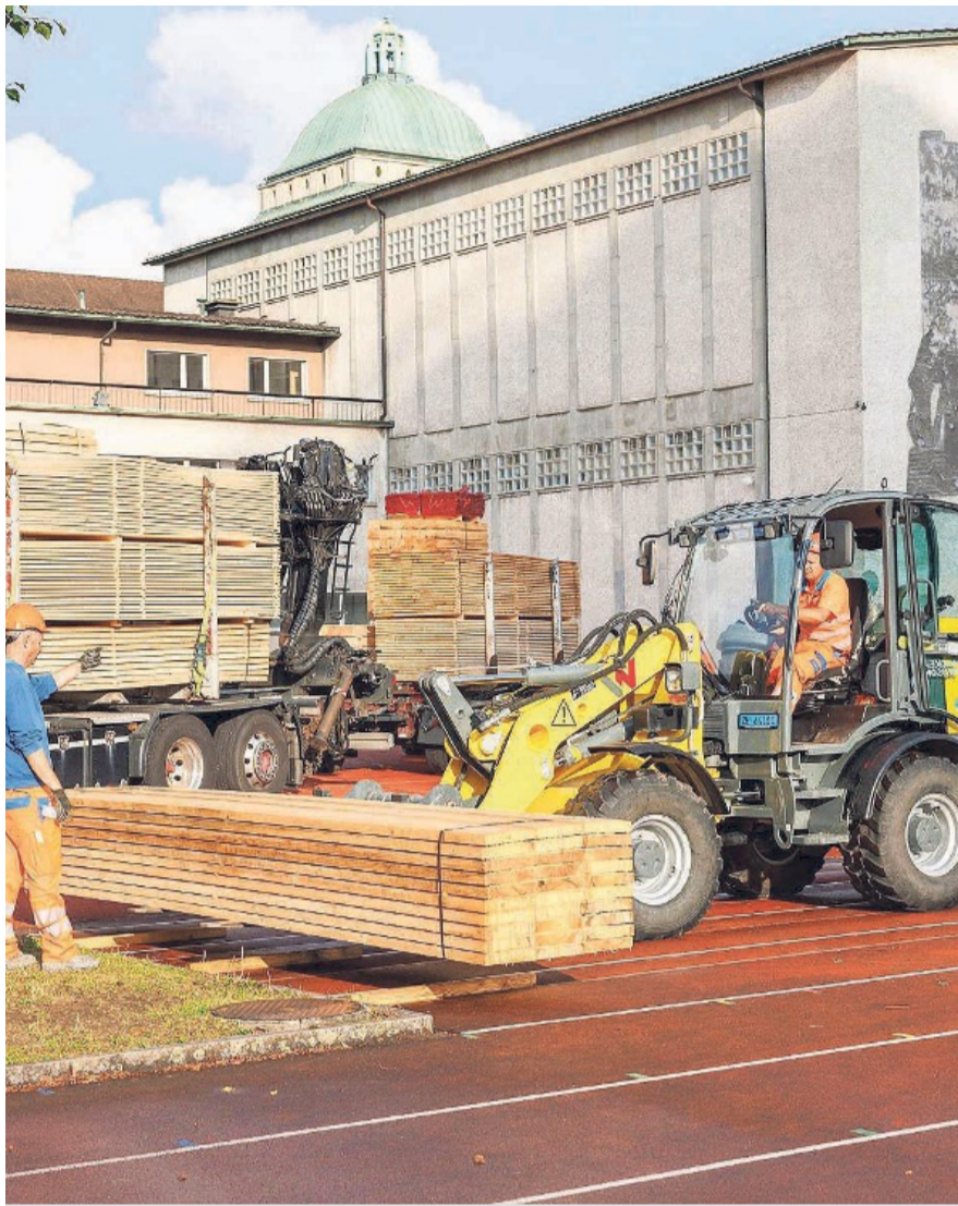
In einem ersten Schritt wurde die Baustelle eingezäunt und eingerichtet.
