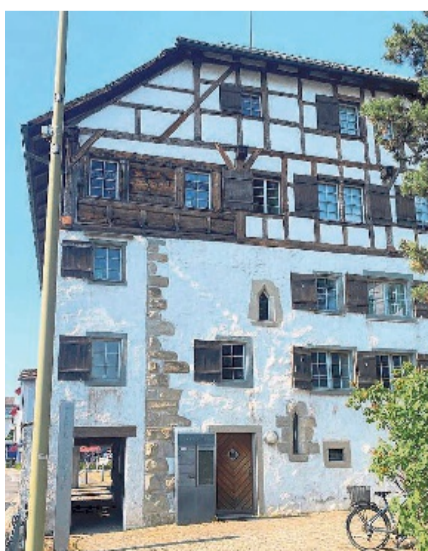
Das Höchhus an der Seestrasse.
